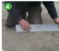
4 Egalisierungsschicht egalisieren
