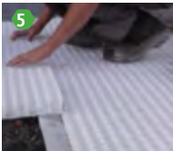
5 Verlegen von ECCOgravel®
