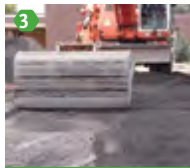
3 Verdichten mit Rüttelplatte
